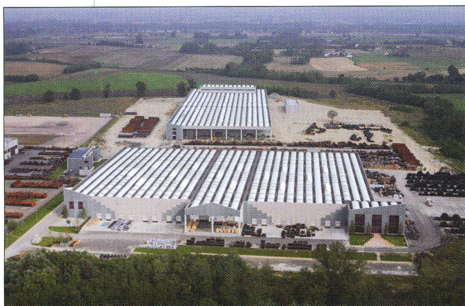
Panoramica del nuovo insediamento produttivo e commerciale di Tectubi Raccordi-Allied Group a Castel San Giovanni (in provincia di Piacenza)
