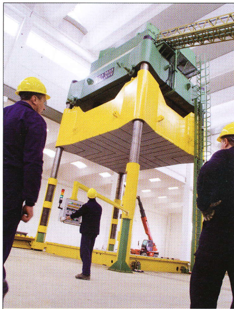
Fase di montaggio della pressa idraulica PHO2-3000
